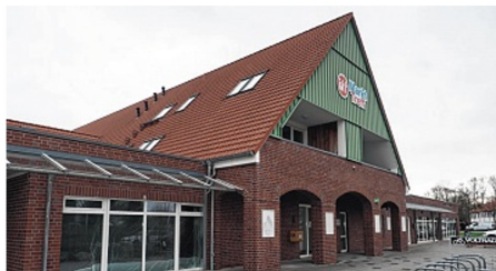
Bald soll neues Leben in die leerstehenden Räume des Markttreffs einziehen. Zurzeit wird kräftig umgebaut.
